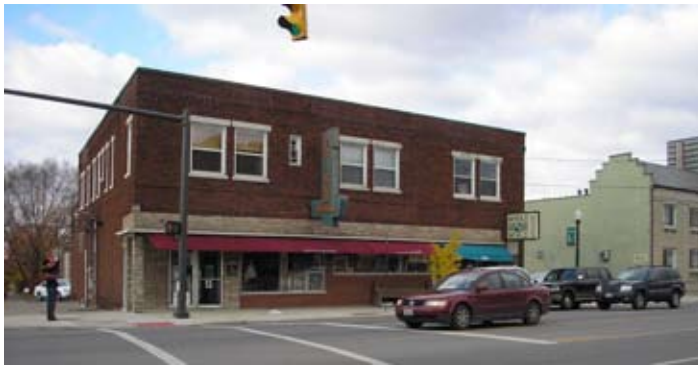
Corner of Como and High Street
